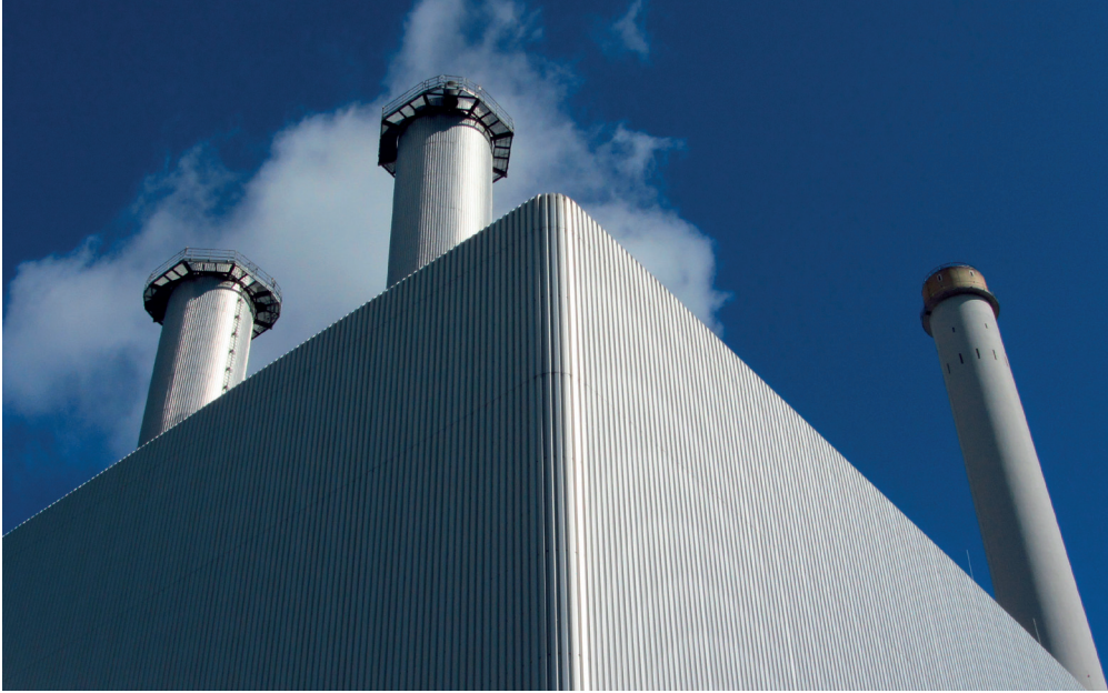
Heizkraftwerk Süd, Stadtwerke München, Foto: Daniel/Flickr
