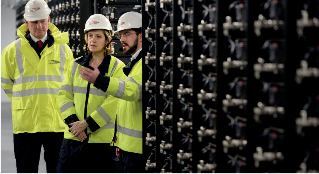
Yunicos-Batteriespeicher der Wemag in Schwerin, Foto Yunicos
